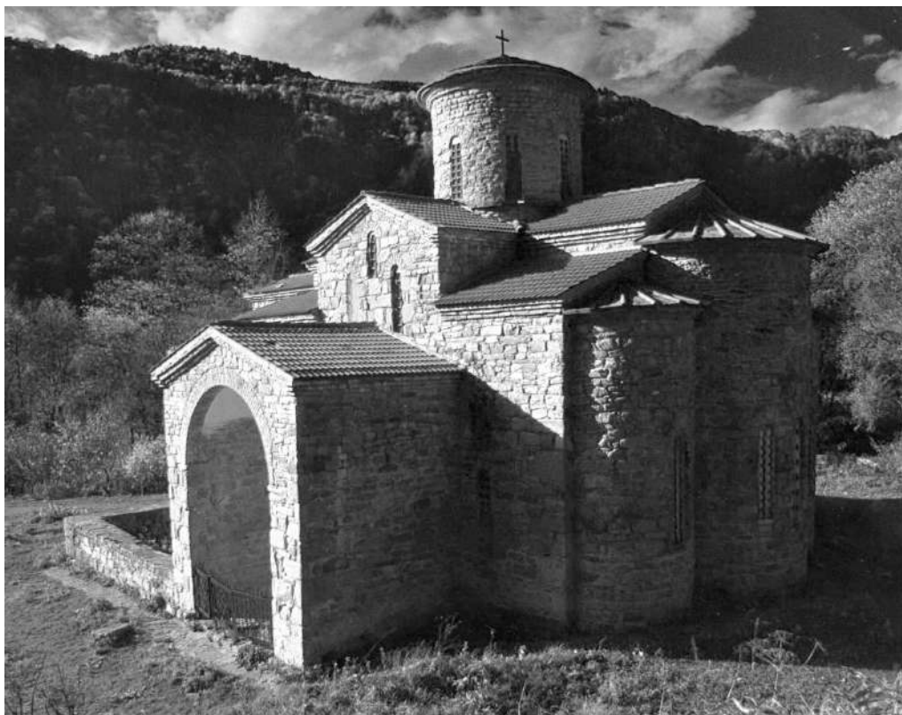
Северный храм после ремонтно-реставрационных работ (современное состояние). Вид с юго-востока
