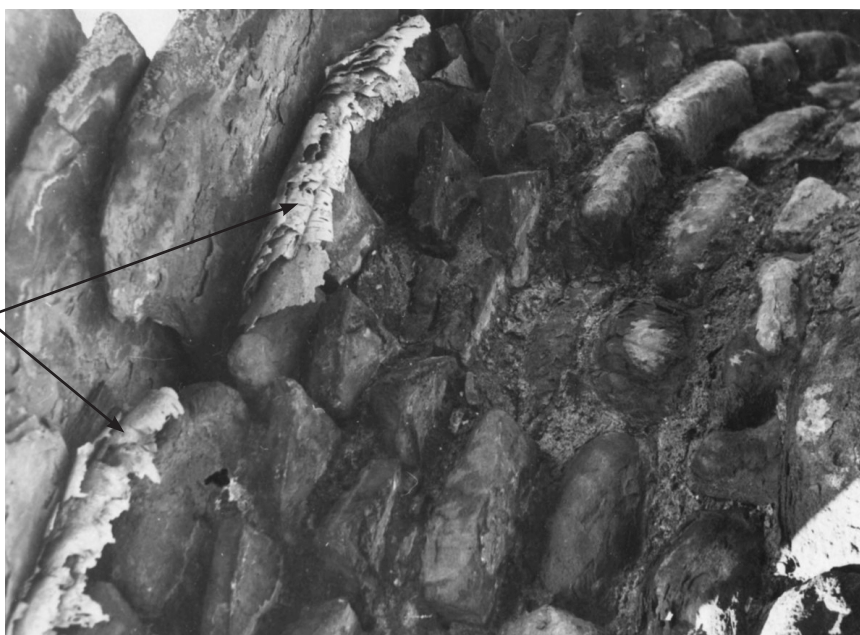
Северный храм, северо-восточная часть барабана с гидроизолирующей прослойкой бересты. Снимок 1960 г.
