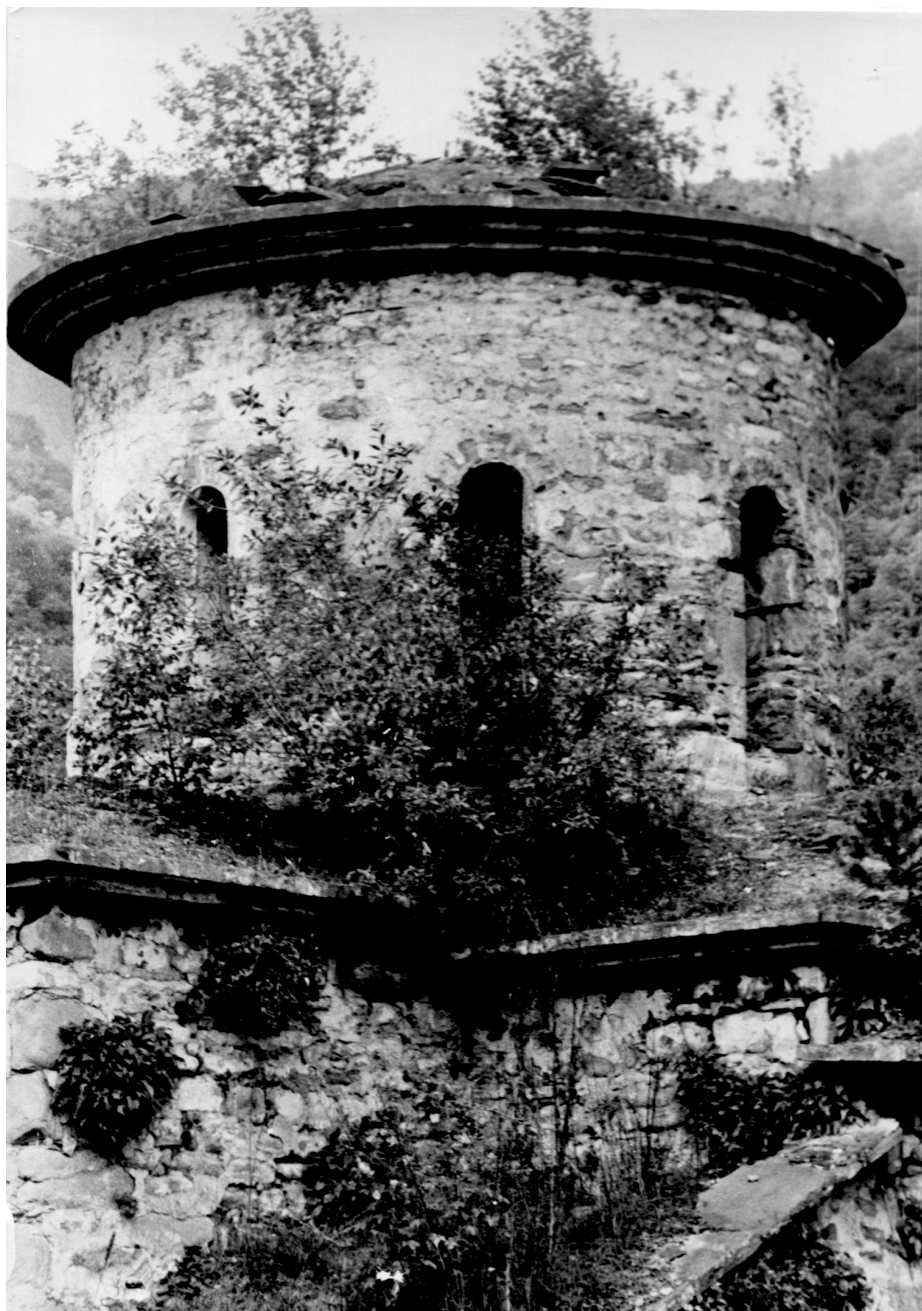
Северный храм, глава храма до начала ремонтных работ. 1970-е годы
