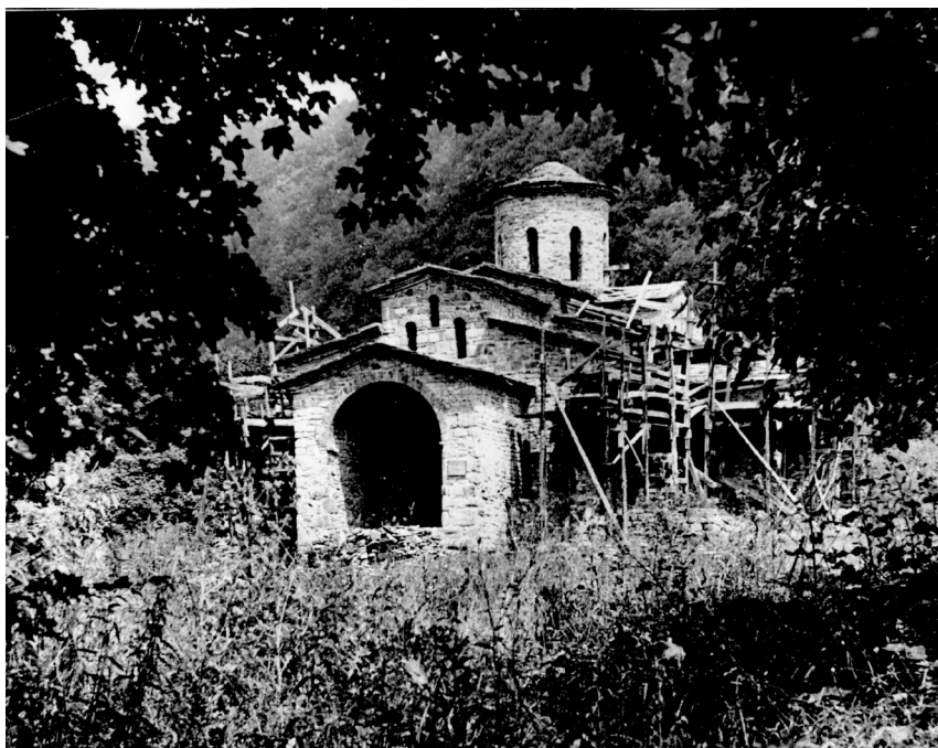
Северный храм в начале ремонтных работ. Вид с юго-запада
