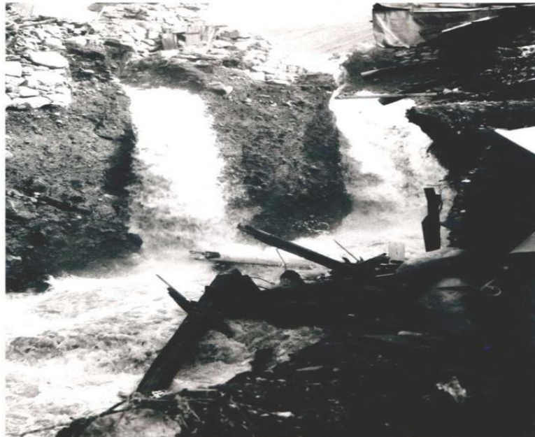
Рисунок 3.20 – Прорыв подпрудных вод р. Адайкомдон у с. Верх. Зарамаг (фото Агибаловой В.В., производственные фонды СОГРЭ, 1987г.).
